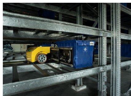
箱式立庫專區中，透過 32 台穿梭車每小時可處理 3,200 個物流箱
